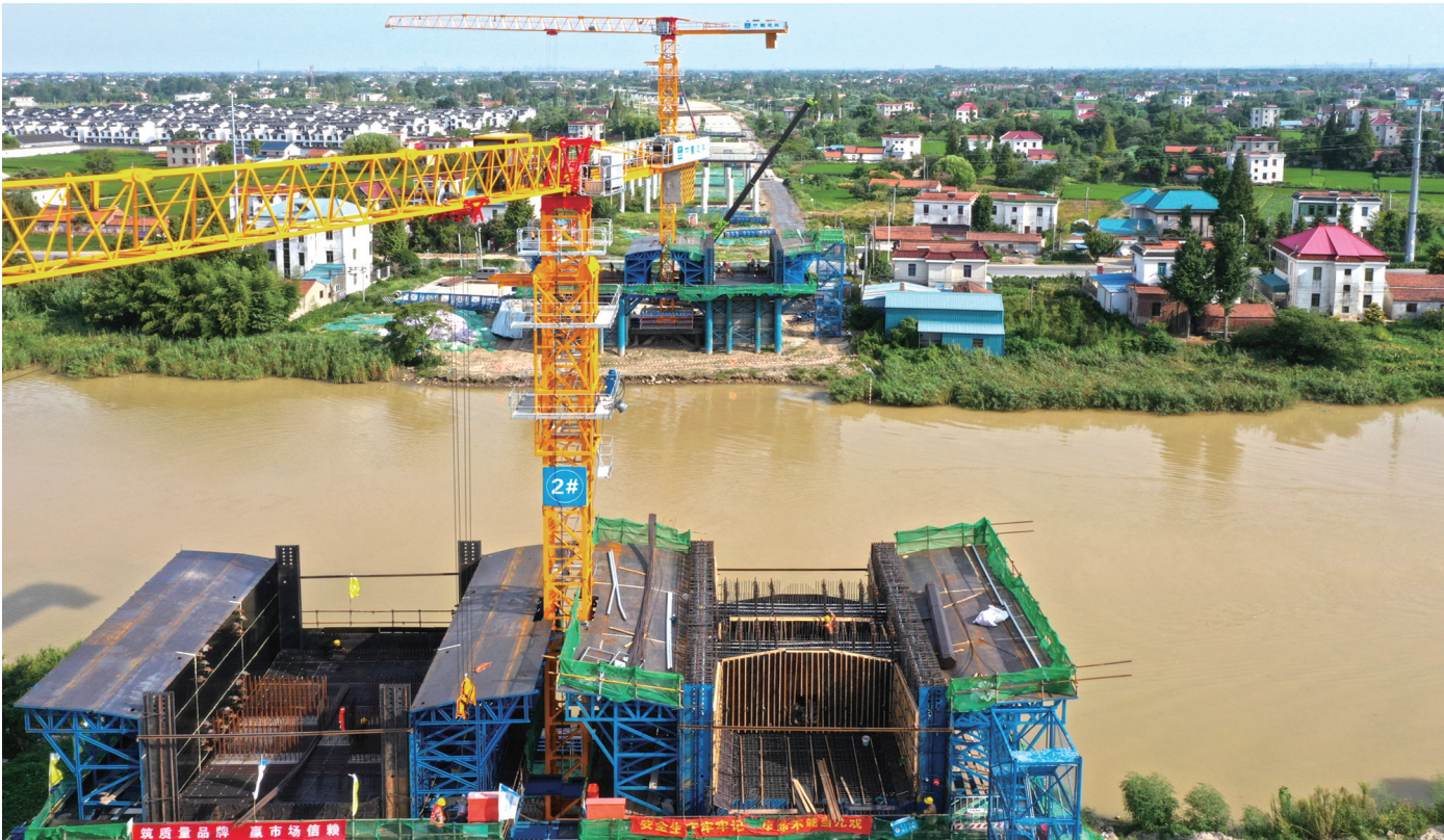
22日,记者拍摄的通州湾港区疏港航道特大桥施工点挂篮0号块施工场地的场景。
