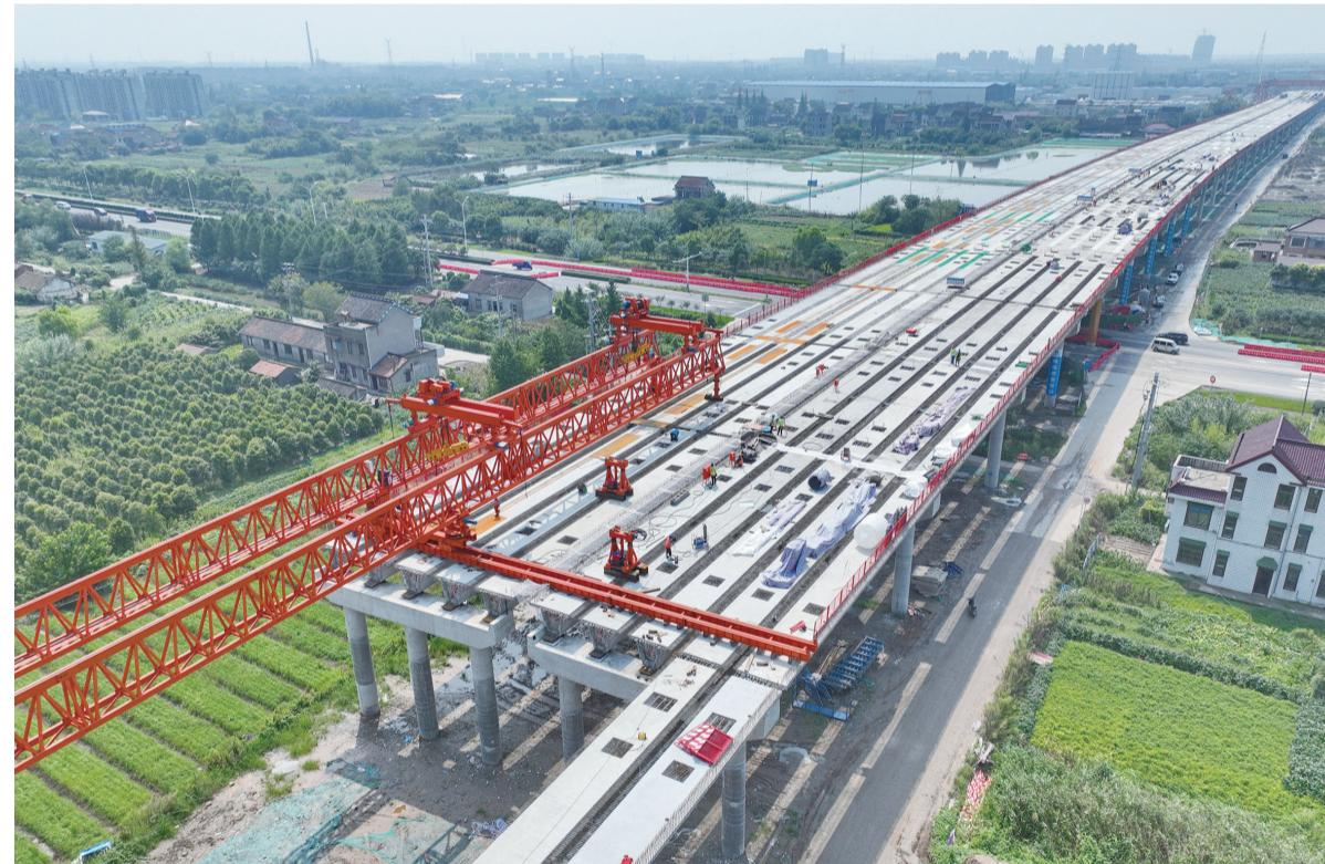
6日拍摄的绕城高速LJ1工区海门主线高架桥施工现场。绕城高速是南通市高速公路网规划的“二环高速”，项目串联了沪苏通等三个过江通道，全长65.4公里，近日，绕城高速疏港航道特大桥首个0#块浇筑完成，标志着绕城高速所有悬浇桥全部进入上部结构悬浇施工阶段。
