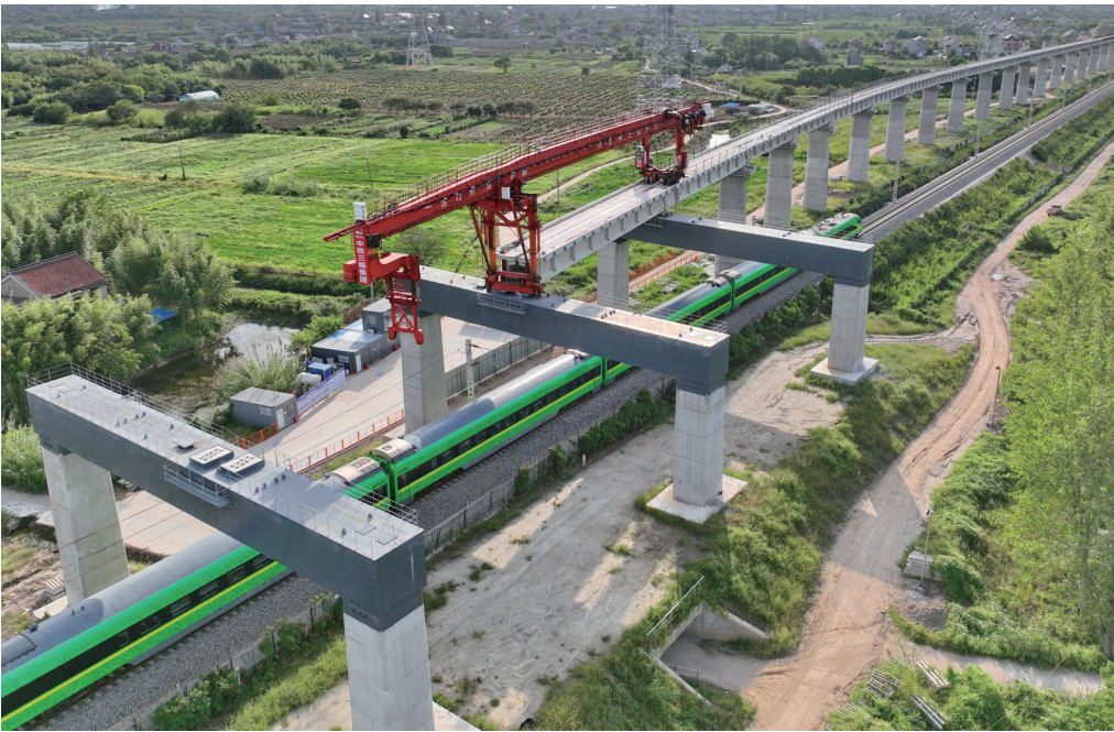
21日在海门区拍摄的南通港疏港铁路上跨宁启线架梁作业现场。
