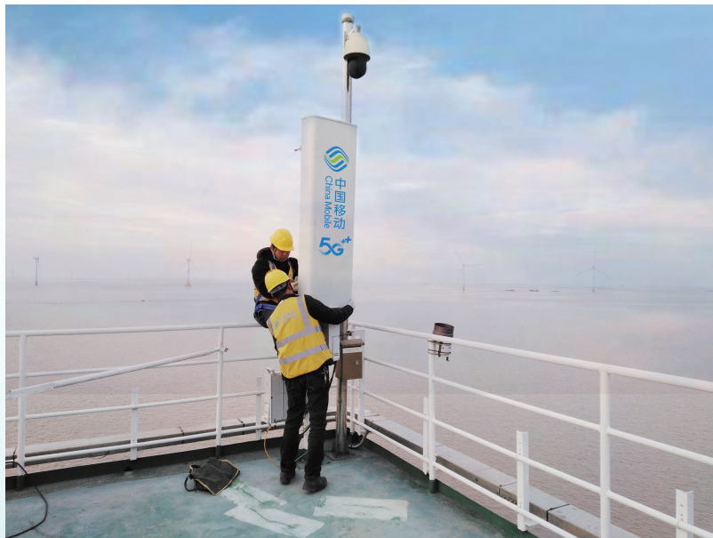
网络施工人员在安装5G设备
