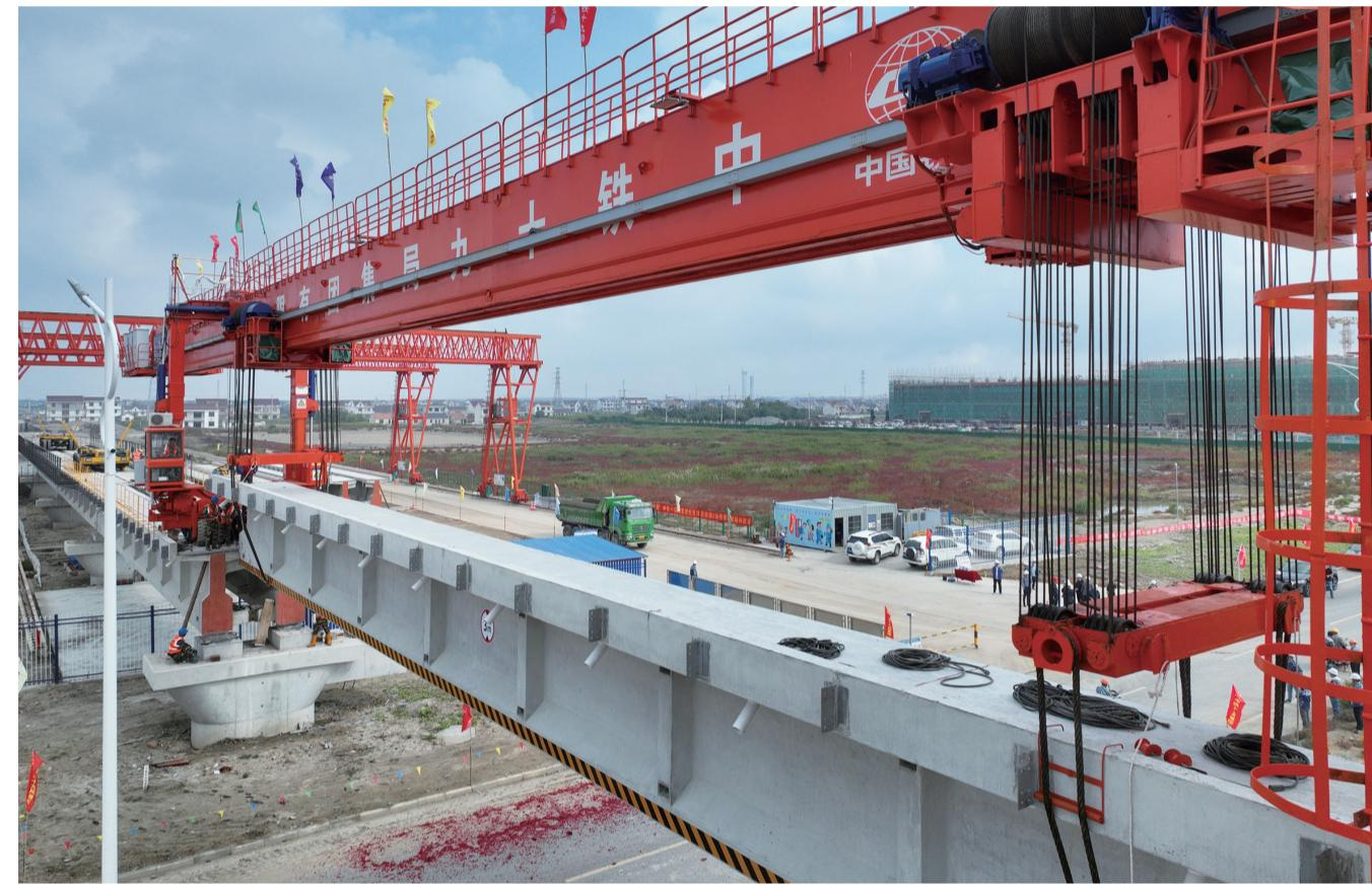
22日,随着重达134吨的铁路混凝土T梁从架桥机腹部徐徐驶出,稳稳落在洋吕铁路2标遥望港特大桥桥墩垫石上,洋吕铁路2标建设进入新征程。
