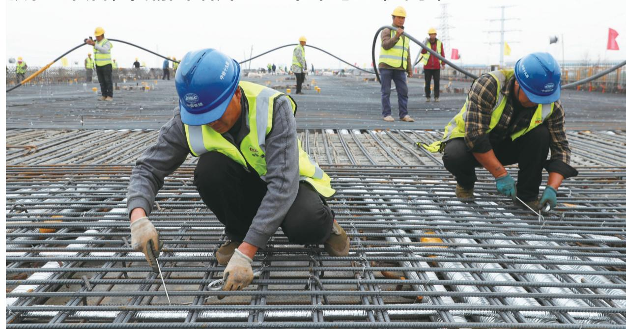
本报讯（记者蒋娇娇）昨天，西站大道（二期）工程主线现浇箱梁最后一个节点开始浇筑。浇筑完成后，标志着历时11个月的西站大道（二期）高架主线现浇箱梁全线贯通。
