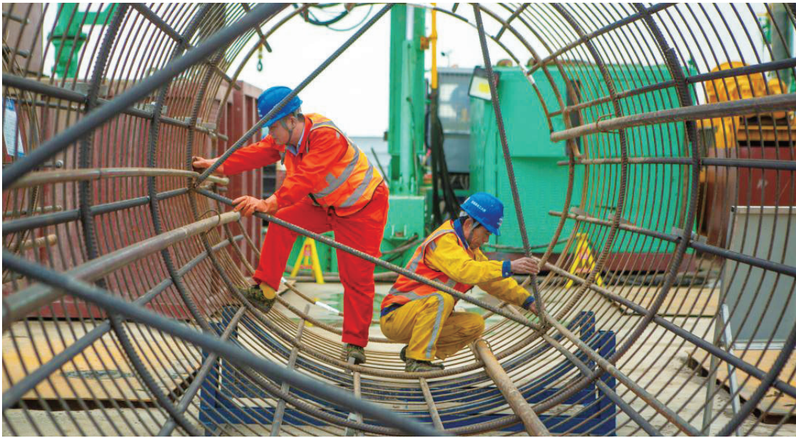
近日,张靖皋长江大桥北航道桥北索塔主墩首根桩基浇筑完成,张靖皋长江大桥北航道桥采用主跨1208米单跨吊悬索桥,此次共计浇筑混凝土592立方米。图为工人正在安装压浆管。 彭军君文 朱洁婷摄
