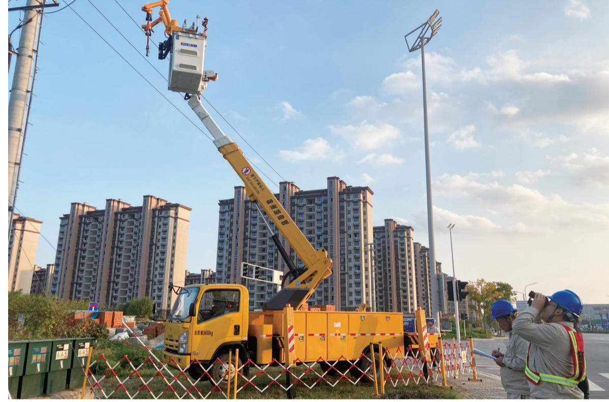
本报讯 (记者徐爱银 通讯员吴天笑)抓线、举线、穿线、避让、剥线、接线、复位……23日上午8点，在通州区江苏博优特环保科技有限公司门口，通州区供电公司带电作业人员俞阳在平板电脑上发出作业指令，操作着绝缘斗臂车的工作斗，稳稳地靠近15米高空中线路(图 吴天笑摄)。两只红色的机械臂缓缓伸出，其中一只手臂“抓住”10千伏线路，准确传递至另一只手臂。轻轻一发力，手臂内置的工具就将外部的绝缘层剥离。按照作业程序，机器人左右开弓，一口气完成线路的安装、固定工作。10千伏增容作业顺利完成，全程用时仅20分钟。
