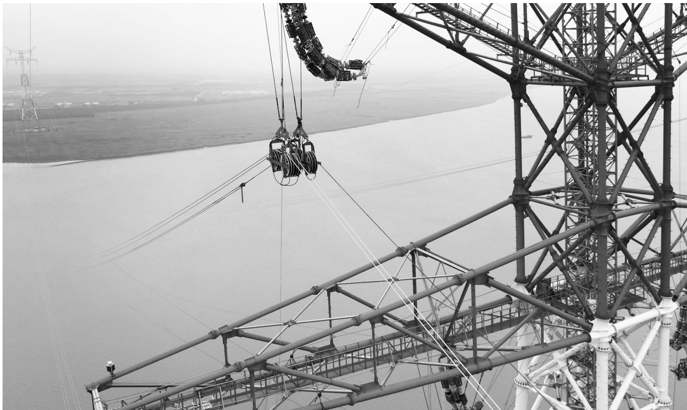
11月29日,500千伏海门东洲—崇明岛输电工程长江北支大跨越在风雨中实施封航展放导线作业。这是崇明岛第一条500千伏外送输电线路,建成之后将提升崇明岛电力外调的能力,以“电力先行”推动长三角能源一体化更高质量发展。 通讯员 黄海摄
