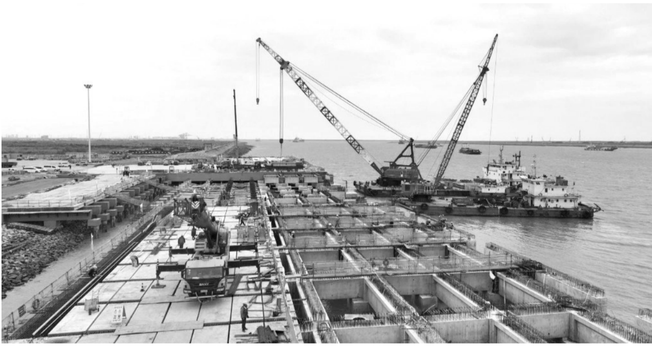
近日,“大于三十天、践行二十大”短途攻坚活动启动仪式在吕四港作业区东港池重装码头举行。东港池重装码头工程将建设1个5万吨级通用泊位,设计吞吐量290万吨/年,项目建成后将为卫华港机、宝安电缆及中外运等企业提供更加便捷的运输通道,促进港区临港产业发展。工程于今年4月开工,将于12月底完工,目前已进入最后冲刺阶段。 潘杨摄
