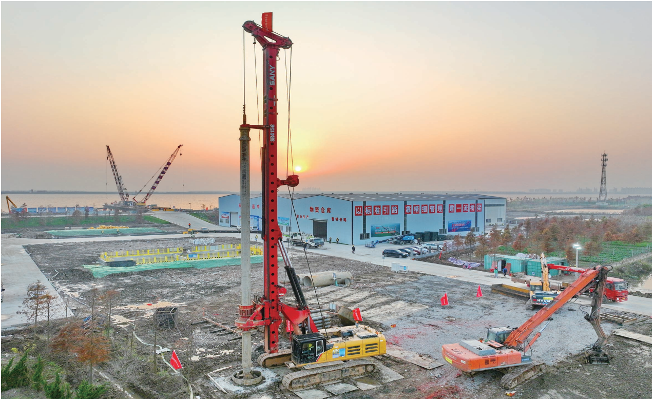
昨天，由中铁大桥局施工的北沿江高铁崇启公铁大桥首根桩孔桩开钻。北沿江高铁上海至南京至合肥段是国家“八纵八横”高速铁路网的重要组成部分。崇启公铁大桥是2线高铁+2线城际+6车道公路的公铁合建桥梁，主通航孔桥铁路引桥。其中主通航孔桥是世界最大跨度公铁两用无砟轨道斜拉桥。
