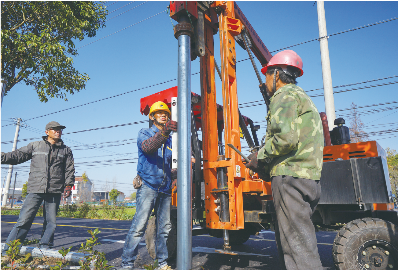
7日,施工人员进行着护栏安装作业。通州区提升农路品质,实施“白改黑”工程,老225线至新225线间的邓九路长2公里,今年投入250万元进行“白改黑”,目前沥青摊铺作业已经完成,进入护栏安装阶段。吉红军摄
