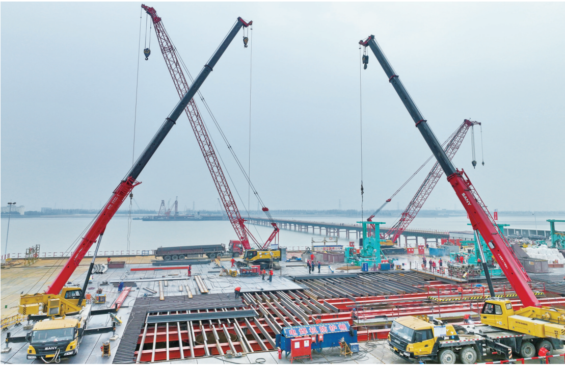
昨天，张靖皋长江大桥水上主塔首根桩孔桩顺利开钻。张靖皋长江大桥南航道桥南主塔高350米，建成后将是世界最高悬索桥索塔，同时也是张靖皋长江大桥四个主塔中唯一一座水上主塔。 记者 许从军摄
