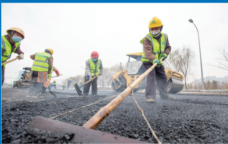
昨天，建设者在海安市世纪大桥改造工程工地上进行沥青摊铺施工作业。 翟慧勇 王菲菲摄
