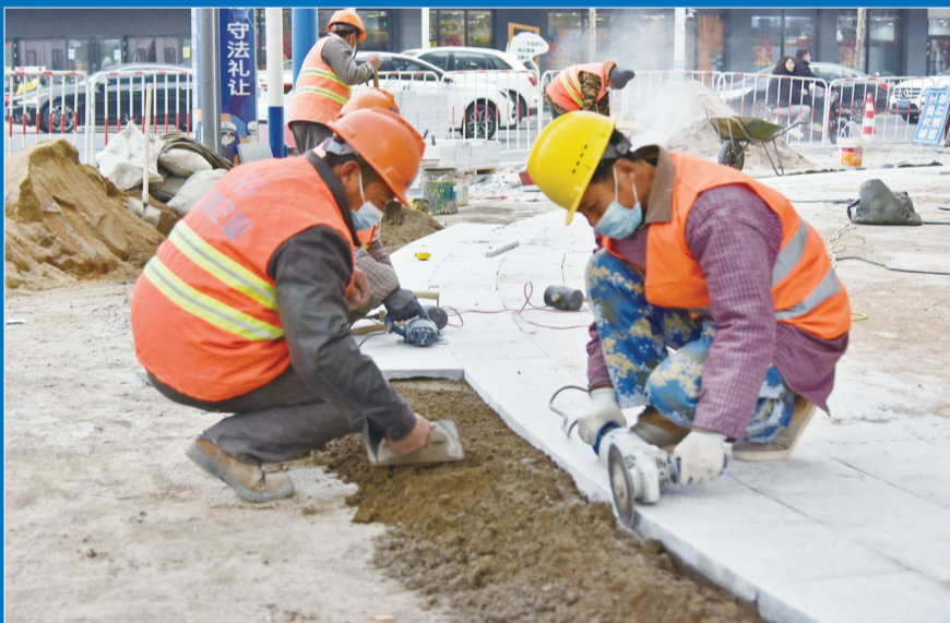
昨天，如皋市政施工人员在坚守在工作岗位上。
