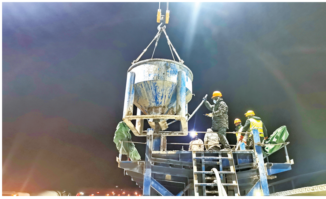
27日23时,中铁四局洋吕项目部迎来了又一个重要工程节点,启东制梁场完成洋吕铁路工程1标主线下T梁预制,为主线通车的目标实现奠定了坚实的基础。 记者 许从军摄
