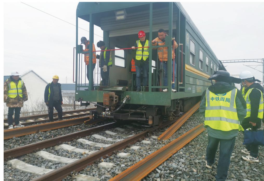
10日7时20分，随着首列运载着11公里500米长轨的T11列车缓缓驶入吕四站，标志着中铁四局洋吕铁路工程1标项目部进入长轨铺设阶段，为实现洋吕铁路主线先导段“3·28”开通目标提供了重要保证。
