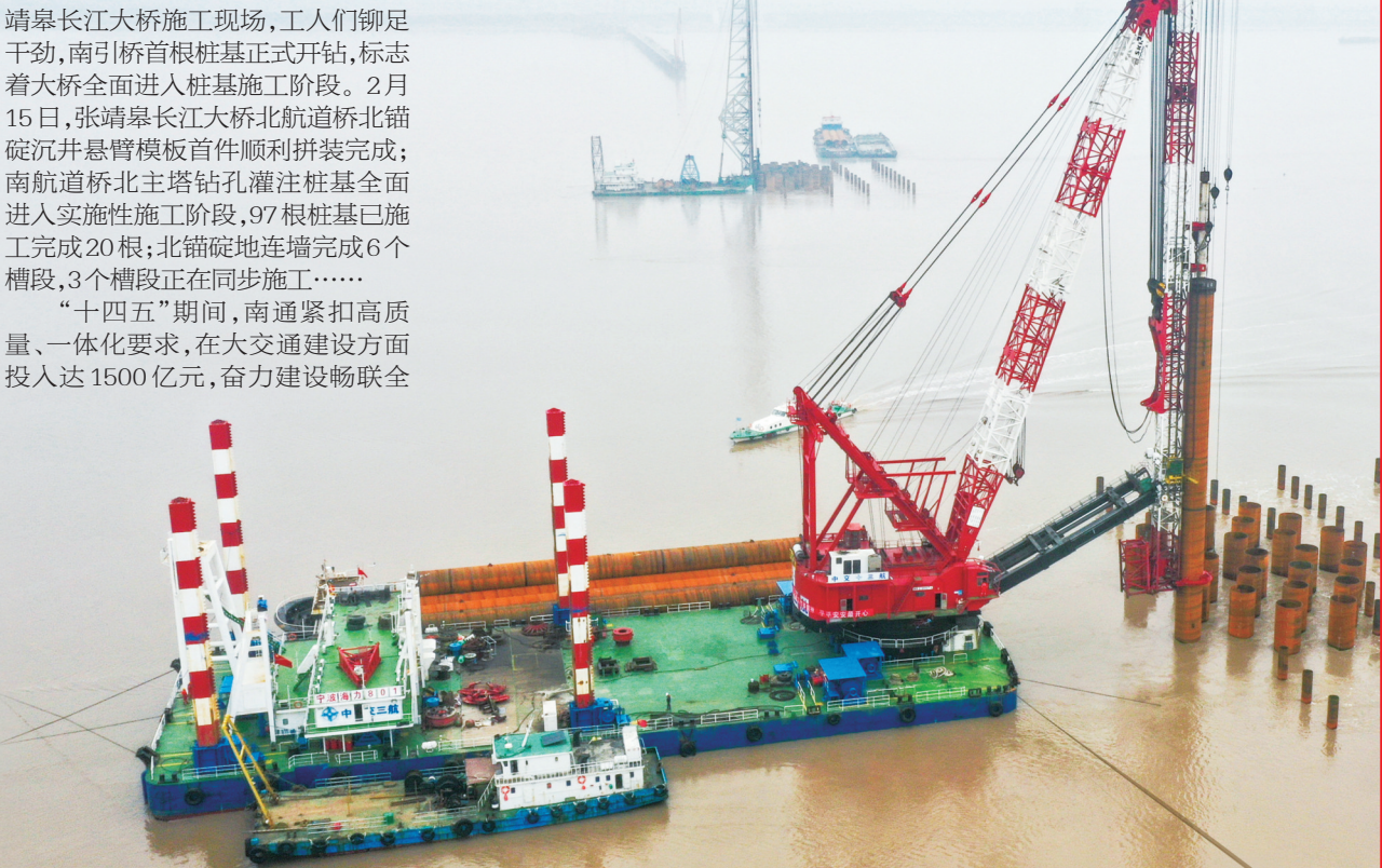
2月18日拍摄的崇启公铁长江大桥永久钢护筒施打作业现场(无人机照片)。 新华社记者 李博摄
