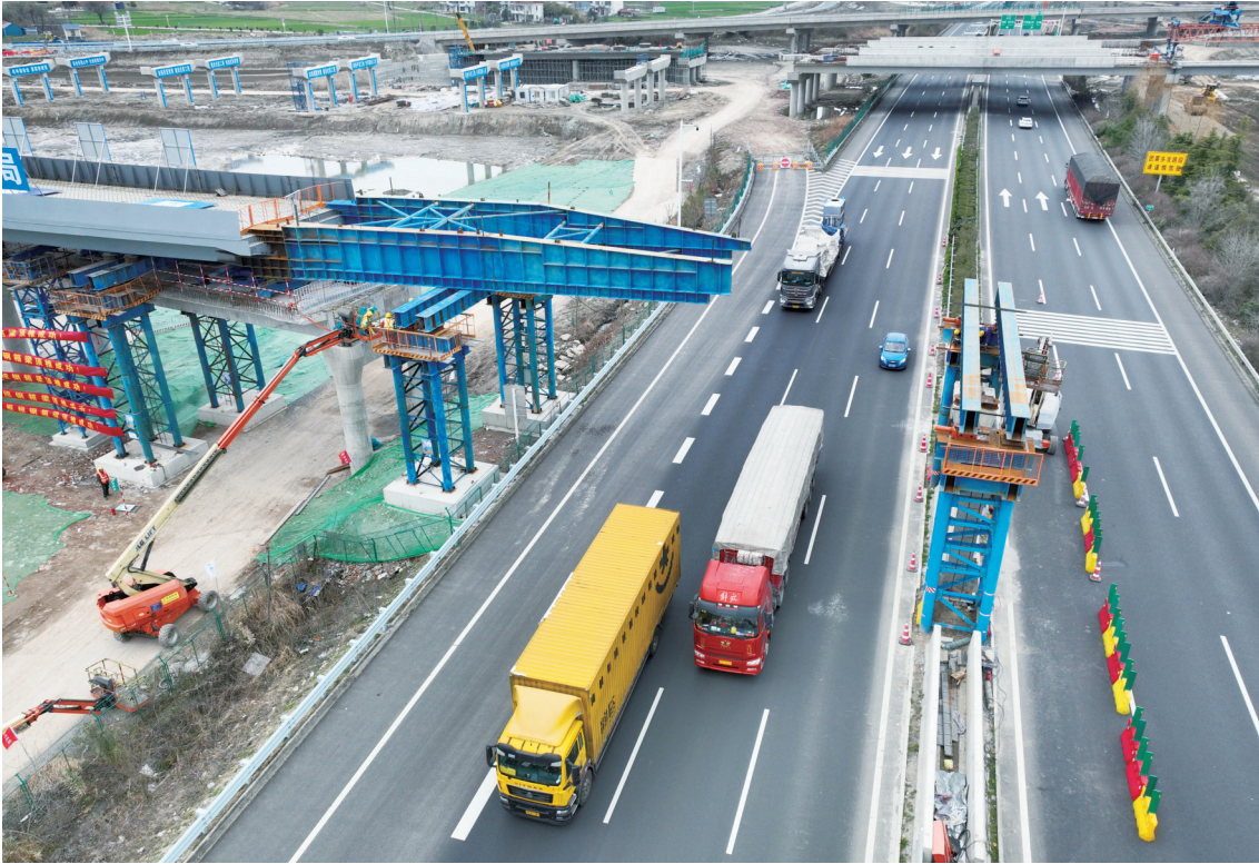
21日,随着一联重350吨、距地面12.8米的匝道钢箱梁缓缓向前推进,稳稳地落在临时支墩上,标志着南通绕城高速公路项目顶推工作顺利启动。南通绕城高速新联枢纽匝道顶推工作具有落梁高度高、梁体纵坡大等特点,在确保不影响下方沈海高速正常通行的情况下,采用在新建梁面上步履式顶推的方式进行施工。 记者 许丛军摄
