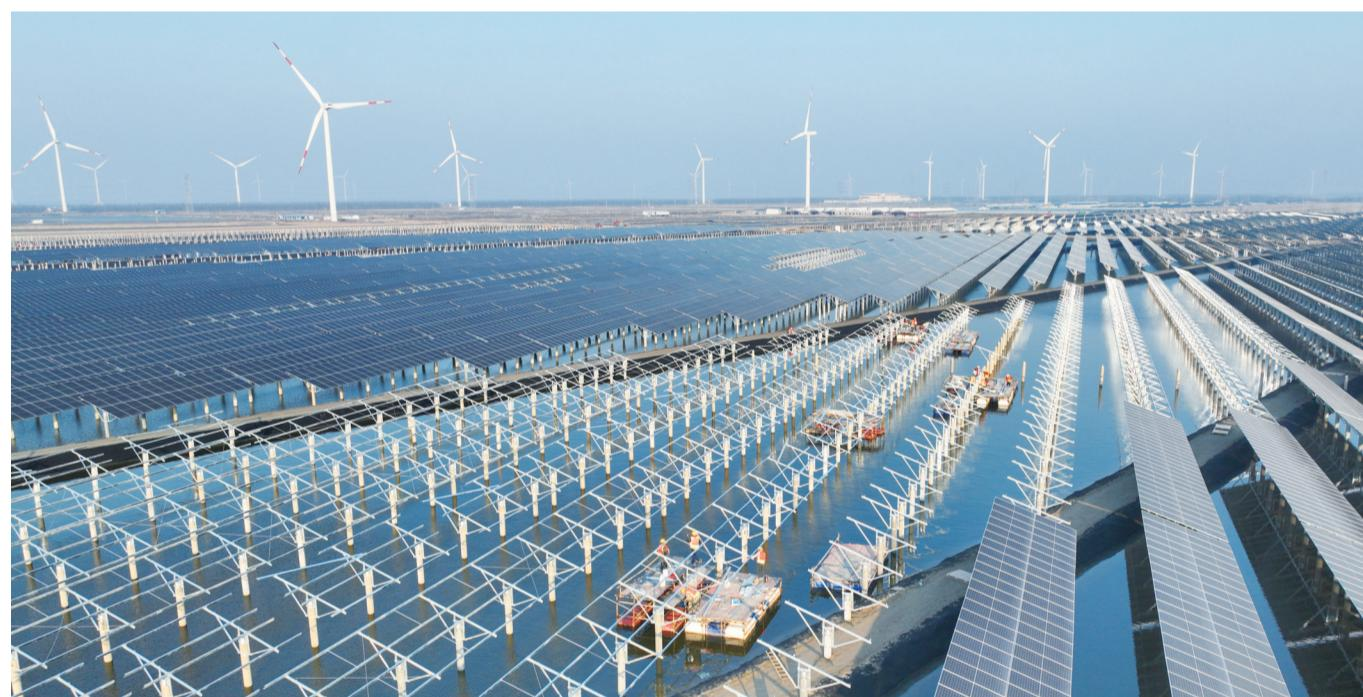
20日，施工人员在施工现场加紧建设。连日来，如东沿海的华能如东200兆瓦“渔光互补”光伏发电项目快速有序推进。该项目占地面积3000余亩，建成后，年均发电量约23390万千瓦时，相当于每年节约标煤7万吨，减排二氧化碳15.43万吨。
