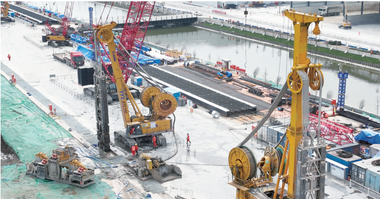
2月28日在海门区拍摄的中铁十四局海太长江隧道A1标项目江北段施工现场。目前,海太长江隧道地下连续墙累计完成97幅,工作井及后续段钻孔灌注桩累计完成61根。
