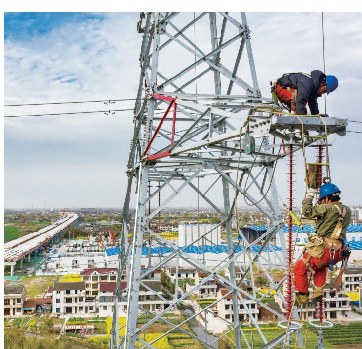
29日下午，国网南通送变电公司施工人员在海门区三厂街道横跨正在建设的锡通高速绕城高速公路上空，完成220千伏六民线提升改迁施工。该工程于昨日通过验收恢复供电。通讯员 黄海摄
