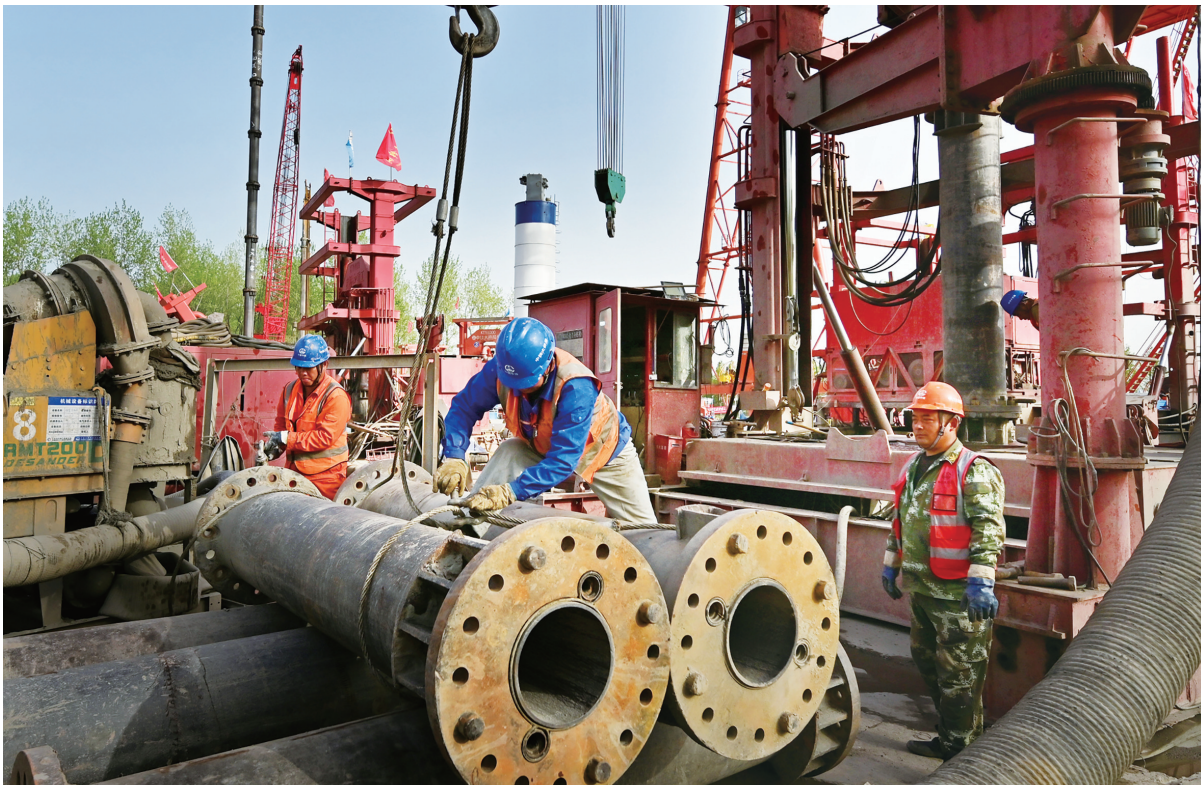
12日下午，位于长江如皋民沙岛上的张靖皋长江大桥ZJG-A2标段，工地建设者们正在干劲十足地推进主塔区打桩作业等工程进度。张靖皋长江大桥主塔区共97根桩，截至目前，已完成72根。
