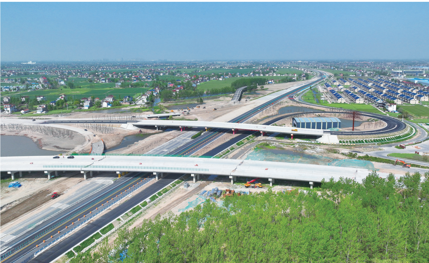
17日在如皋九华镇拍摄的沪陕高速公路平潮至广陵段扩建工程PGK—NT1施工现场。PGK—NT1标预计今年年底完成全部施工任务,具备通车条件。该标项目路线全长6.86公里,由原有的双向四车道改扩建为双向八车道。
