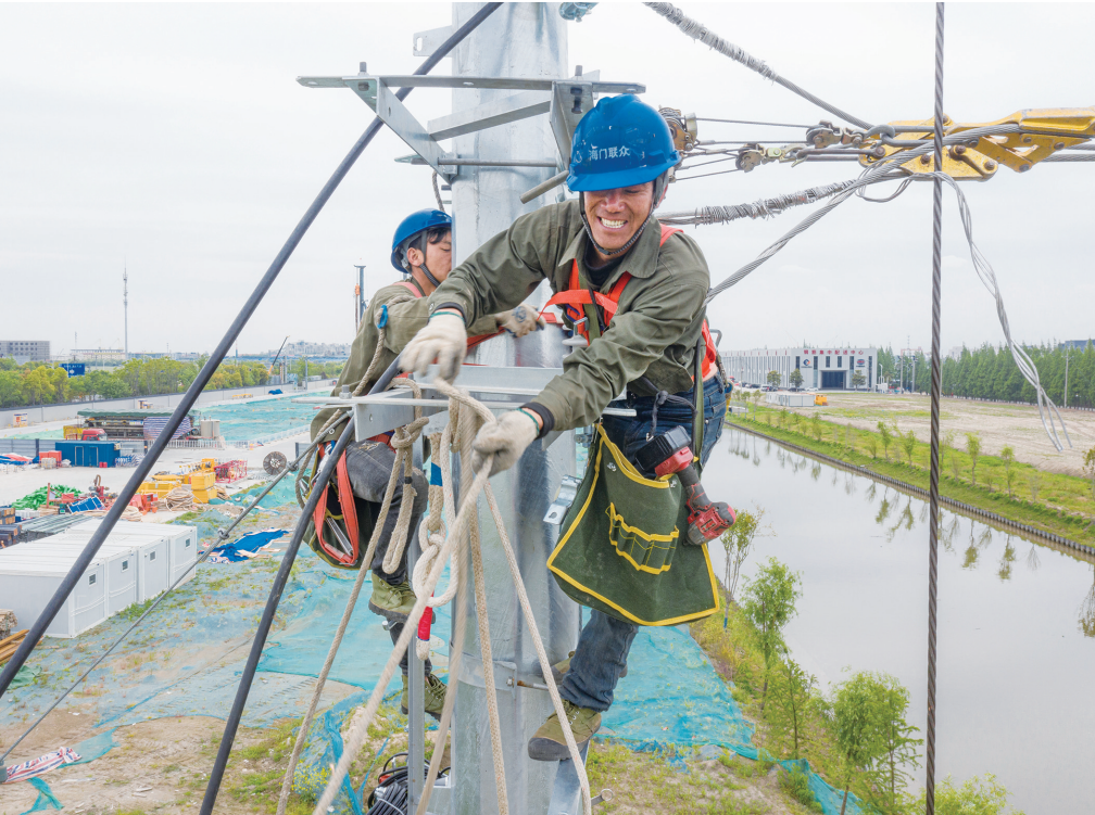
昨日，国网南通市海门区供电公司（联众公司）施工人员在海太过江通道盾构施工工地外围，进行10千伏江心沙线路改迁作业，避让过江通道正面空域改为地下电缆穿越，同时为盾构沉井开挖提供临时电源。 海太过江通道起自南通市海门区，止于太仓市沪武高速，全长39.07公里，其中过江隧道总长11.2公里，是国家2025年前重点建设的公铁复合过江通道。 黄海摄
