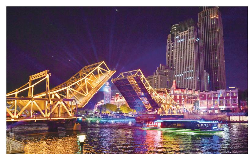
1日,一艘海河游船通过开启的解放桥。当晚,位于天津海河上的标志性建筑物解放桥桥梁开启,桥梁开启角度达到最大角度60度。新华社照片
