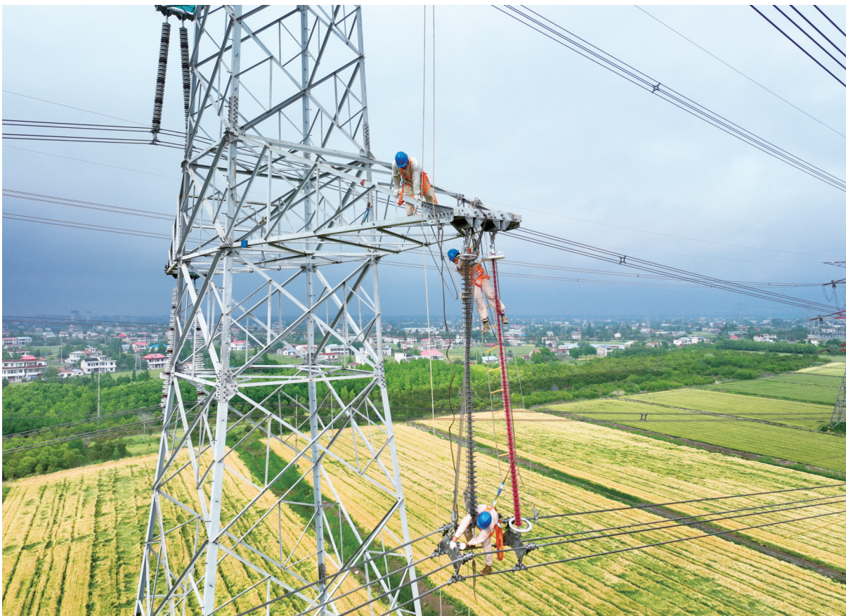
昨天,南通供电公司输电运检中心工作人员在高空作业。5月4日至6日,南通供电公司输电运检中心利用华能苏通电厂停机检修的时间,对电厂到500千伏官殿变电站之间的线路开展全线综合检修。 记者 许丛军摄
