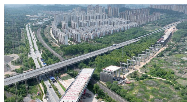
昨日，转体桥在转体中。当天转体重量14000余吨的武汉绕城高速改扩建转体桥成功转体，在100分钟内顺时针旋转71度，跨越武九铁路和森林大道公铁大动脉。
