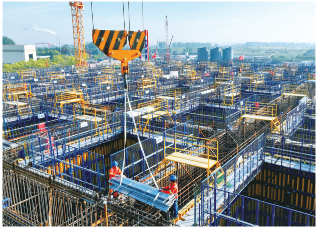
昨天凌晨4时许，由中交一公局集团有限公司承建的世界最大跨度桥梁——张靖皋长江大桥北航道桥北锚碇沉井基础首次接高混凝土浇筑完成，标志着该大桥北航道桥北锚碇沉井接高施工进入新阶段。据了解，北航道桥北锚碇沉井接高混凝土浇筑达66小时，浇筑混凝土7936立方米。
