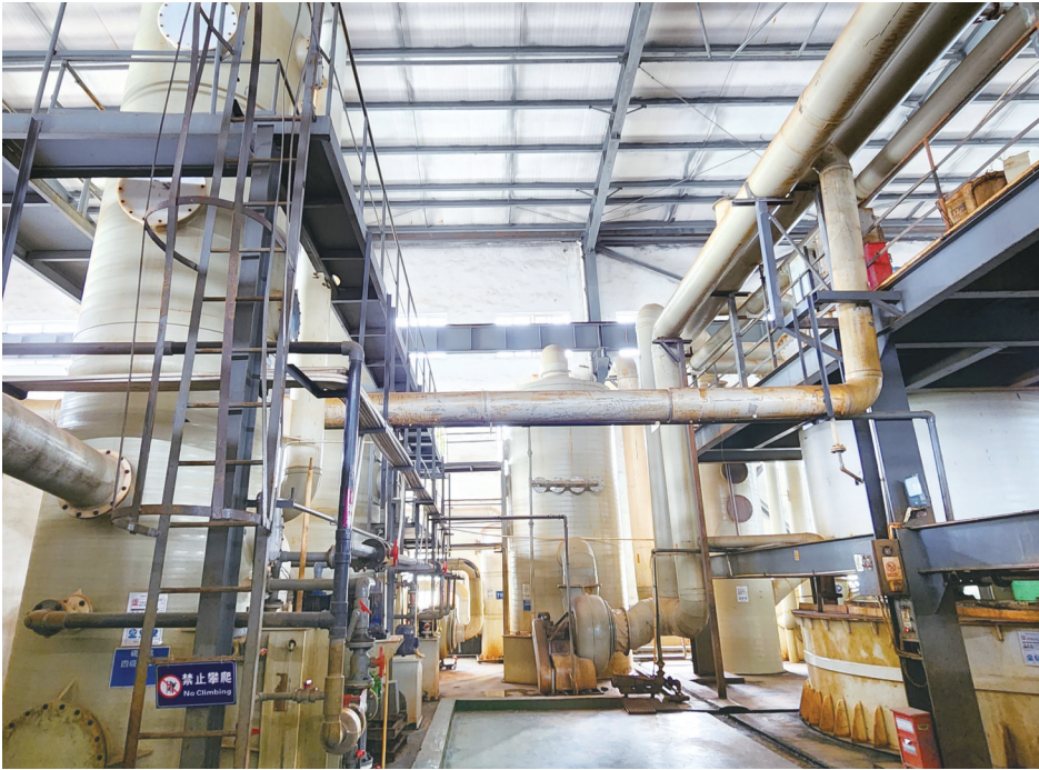
去年改造完成的废气回收处理装置。
