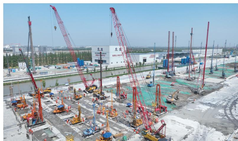
本报讯（记者许丛军）随着 5 月初海太长江隧道江北段地下连续墙施工全部完成，工程正式进入基坑基底加固和开挖施工阶段。在中铁十
