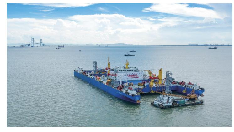
“一航津安1”号沉管运输安装一体船在沉放安装E23管节和最终接头,背景是建设中的深中通道伶仃洋大桥。新华社照片
