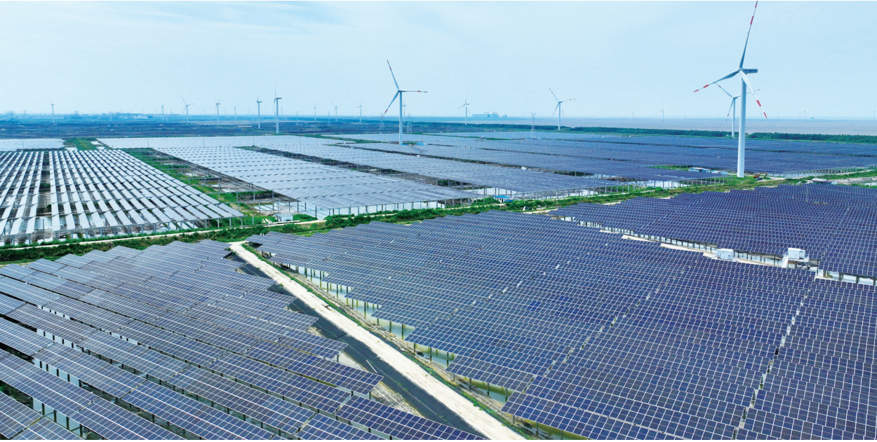
28日在如东县拍摄的“渔光互补”光伏发电项目。如东县沿海的华能如东200兆瓦“渔光互补”光伏发电项目组件安装即将完工,升压站完成基础施工,GIS、SVG、预制舱、主变一安装完毕。项目建成后,年均发电量约23390万千瓦时,相当于每年节约标煤7万吨,减排二氧化碳15.43万吨。
