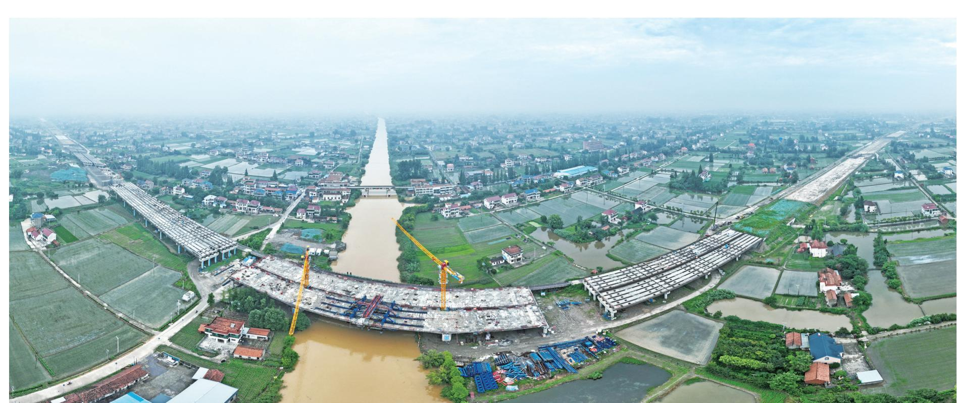
近日，南通绕城高速公路项目三工区疏港航道特大桥和江海河大桥主桥悬浇梁相继合龙，标志着这两座大桥主桥双幅已经贯通，为后续绕城高速全线通车奠定了坚实基础。图为昨天拍摄的江海河大桥建设现场。
