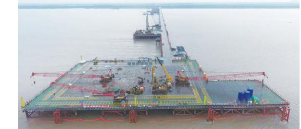
本报讯（记者彭军君 实习生朱冰彦）昨天6时许，崇启长江大桥3号墩顺利完成最后一根桩的混凝土浇筑。至此，这座大桥的水上桩基施工全部完成（上图 崔永兴摄）。
