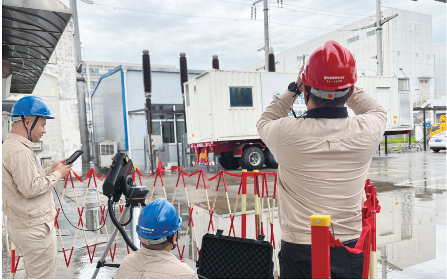
7月7日,南通供电公司输电中心运检员工使用“激光炮”击落挂线异物,确保强对流天气下输电线路安全运行。
