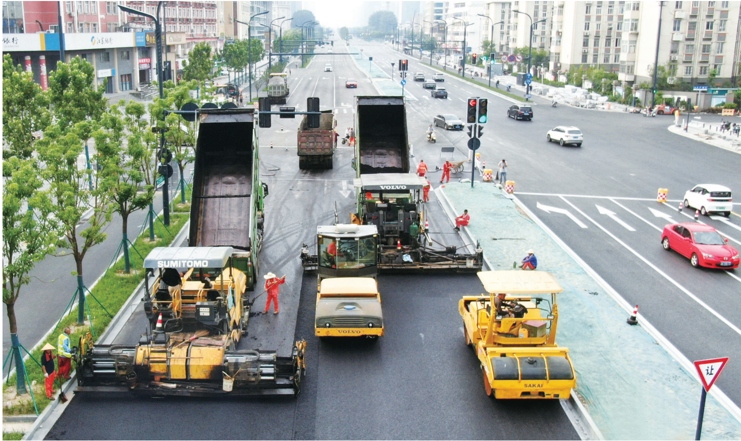
13日，施工人员在工农路(青年路至虹桥路段)东半幅摊铺最后一层沥青。
