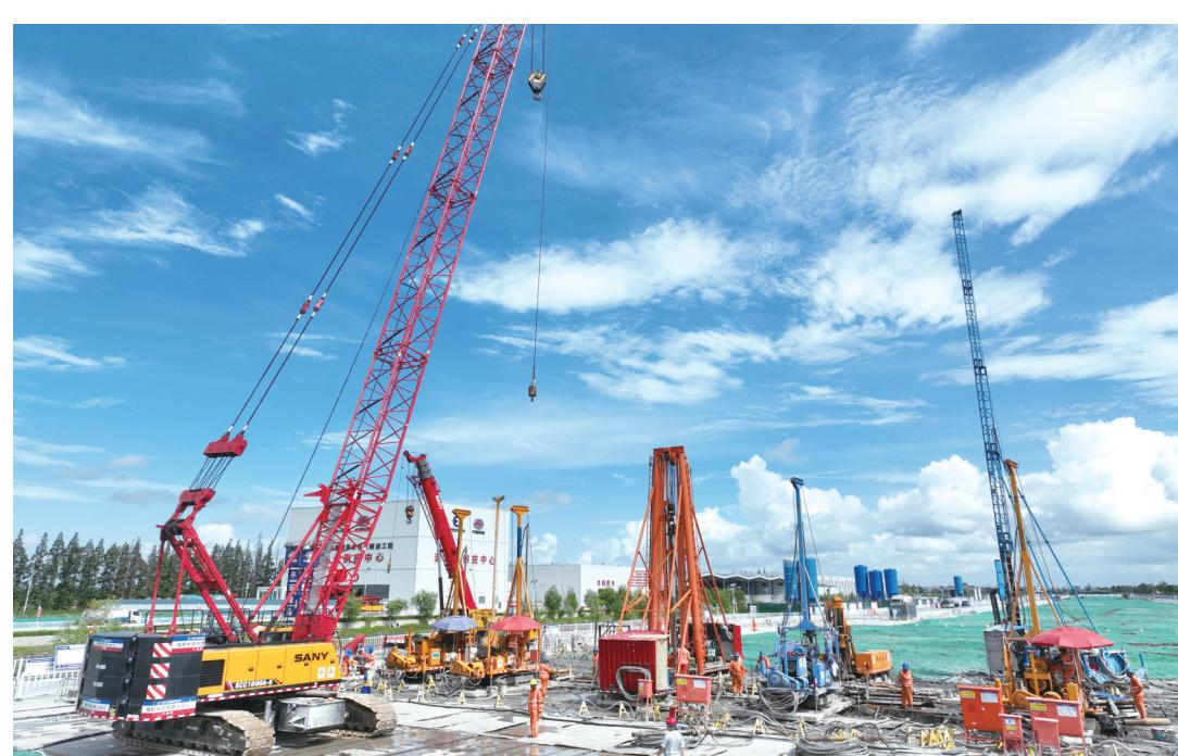
昨日在海门拍摄的海太长江隧道施工现场。目前，海太长江隧道江北明挖段隧道围护已全部完成，正开展高压旋喷桩加固、超高压基底加固及地墙接缝止水施工。海太长江隧道是“十四五”重点推进的过江通道项目，堪称“万里长江第一隧”，连接太仓、常熟和海门，建设工期6年，计划于2028年建成通车。
