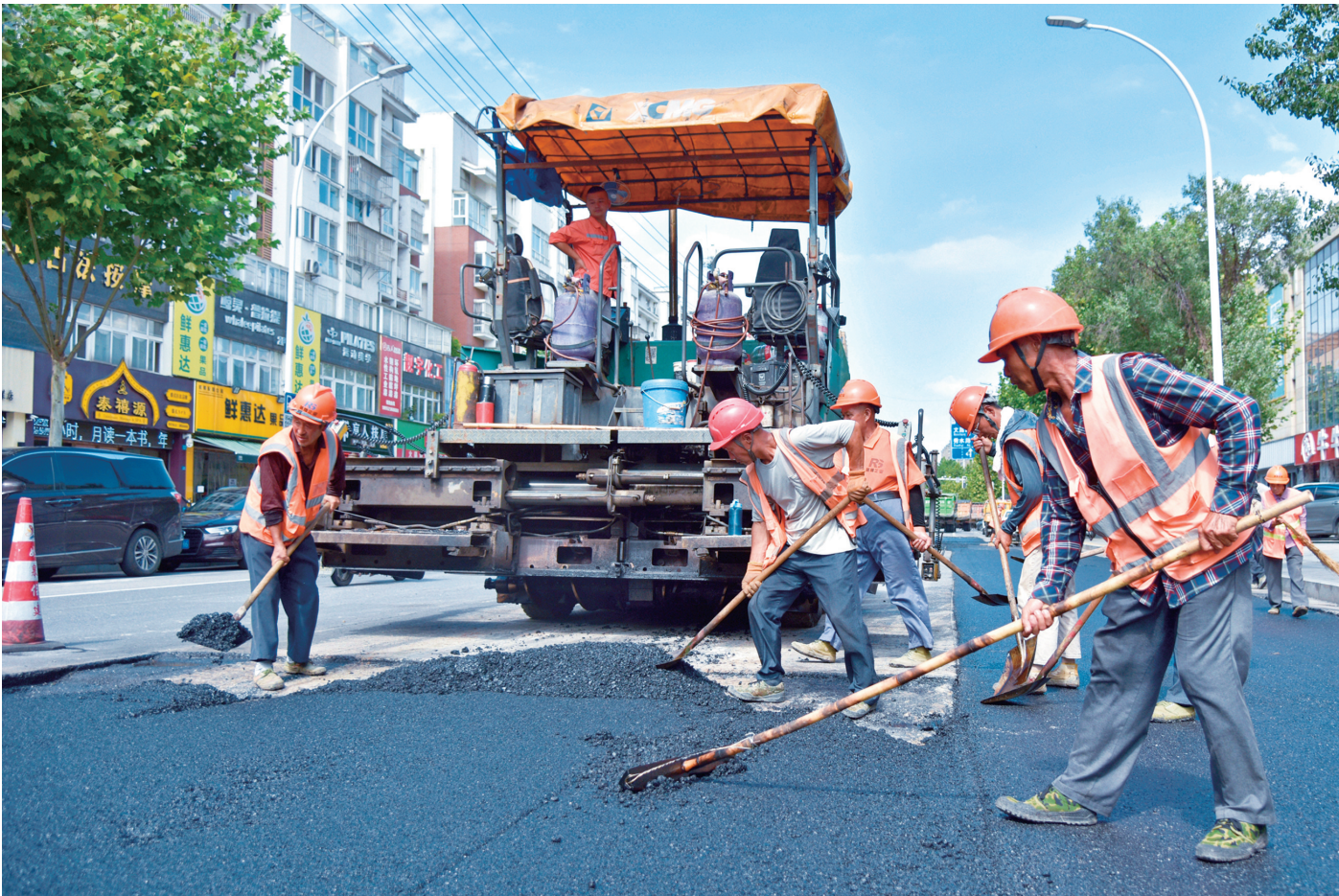
昨天,如皋宁海路“小维修”工程施工现场,市政养护工人正冒着烈日进行路面摊铺沥青混凝土作业。近日,如皋夏季道路维修养护工作全面展开,市政管理部门抓住时节对破损路面进行“小维修”,以提高路面强度和承载能力,确保市民便利出行。 吴树建摄
