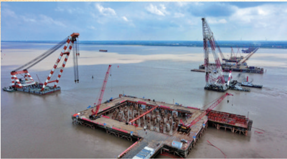
2023年8月8日,沪渝蓉高铁崇启公铁长江大桥施工现场,施工单位中铁大桥局正在进行4号主墩钢围堰吊装下放现场演练,大桥海宇1200吨吊船和稳强3号1300吨吊船江面计划模拟演练吊装,为8月下旬4号主墩钢围堰正式吊装下放做好充分准备。
