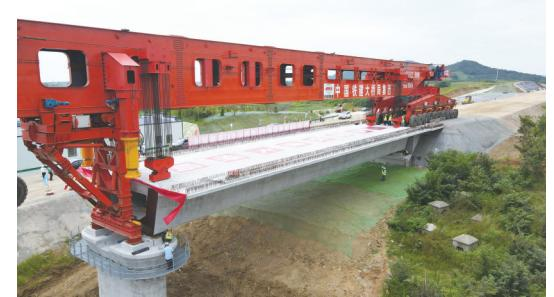
据新华社电 8月27日,在中国铁建大桥局北沿江高铁(新建上海至南京至合肥高速铁路)箱梁架设现场(上图),随着重930吨的箱梁稳稳地架设在合肥东南段特大桥墩上,标志着新建沪宁合高铁全线首榀箱梁成功架设,施工进入全线架梁阶段。
