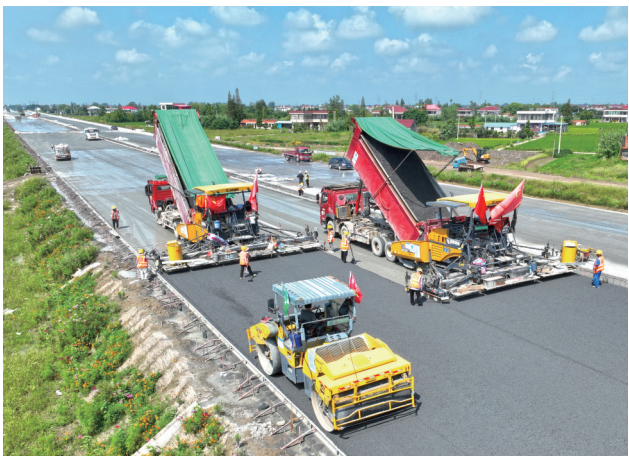
昨天，南通绕城高速LM2标段工地上，建设者们正挥汗如雨加油干。绕城高速现已进入路面水稳摊铺施工阶段，目前底基层水稳完成率已逾35%，整个水稳施工预计在今年年底前完成。 记者 丁传彬摄
