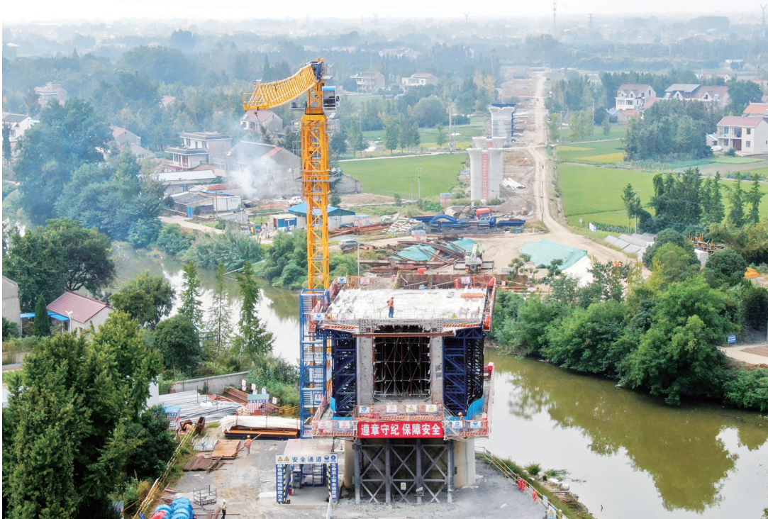
26日,无人机航拍沪渝蓉高铁(北沿江高铁)如皋段,施工人员正在进行端头凿毛作业。日前,由中铁十四局承建的沪渝蓉高铁通泰扬特大桥首个连续梁主墩0号块顺利浇筑完成,桥梁工程建设正式转入上部结构施工阶段。
