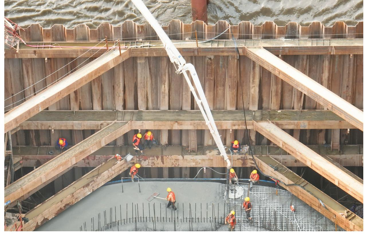
27日,由中铁大桥局承建世界在建最大跨度双塔双索面公铁两用无砟轨道斜拉桥——崇启公铁长江大桥首个水中承台混凝土浇筑完成,大桥基础施工取得阶段性重大进展。
