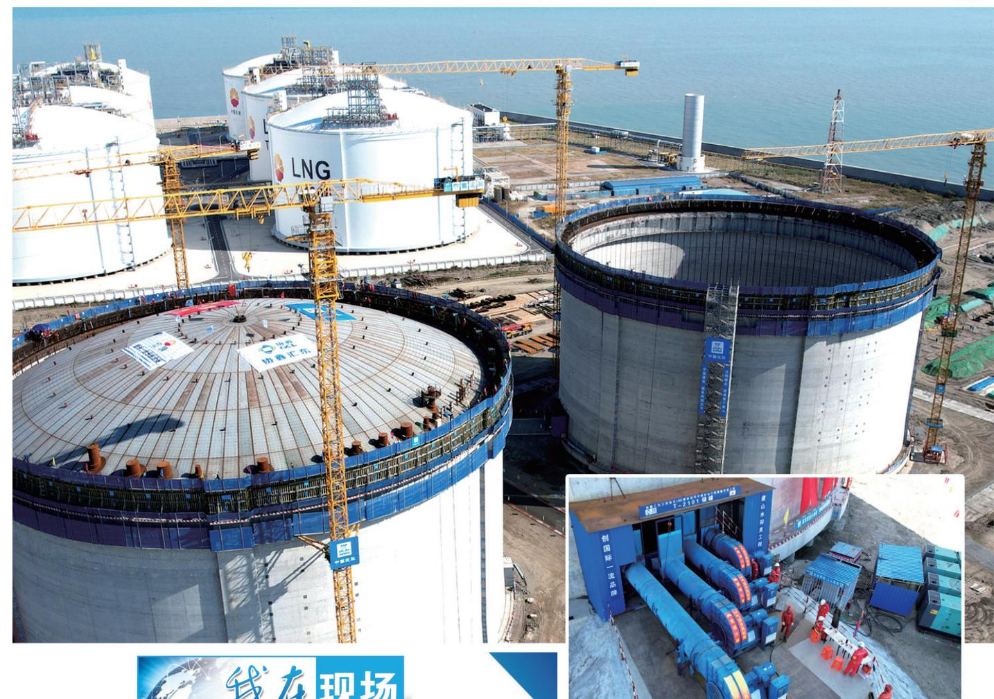
昨天上午9点40分,如东洋口港阳光岛协鑫江东如东LNG接收站项目现场,在4台鼓风机连续130分钟不间断“充气”下,一顶由36块钢结构板组成、总重达900吨的“巨型锅盖”平稳升至45米高空,随着拱顶板与承压环完美对接,T-2102号储罐气顶升作业各项准备工作,预计本月底前完成2号罐顶升作业。
