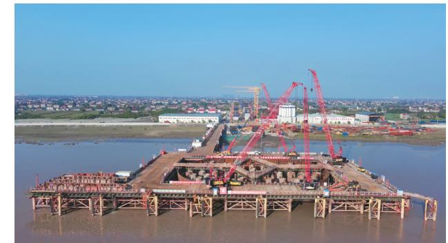
本报讯 (记者彭军君 通讯员李梦竹)10月底，崇启公铁长江大桥迎来开工建设一周年。29日，中铁大桥局再传捷报：崇启公铁长江大桥3号、4号主墩钢围堰第四节拼装完成，两个钢围堰预计11月上旬吸泥下放到位后开始灌注水下封底混凝土。一年来，大桥建设全面提速，进场人员上千人，进场机械设备上百台套，累计完成16.3%的进度产值。
