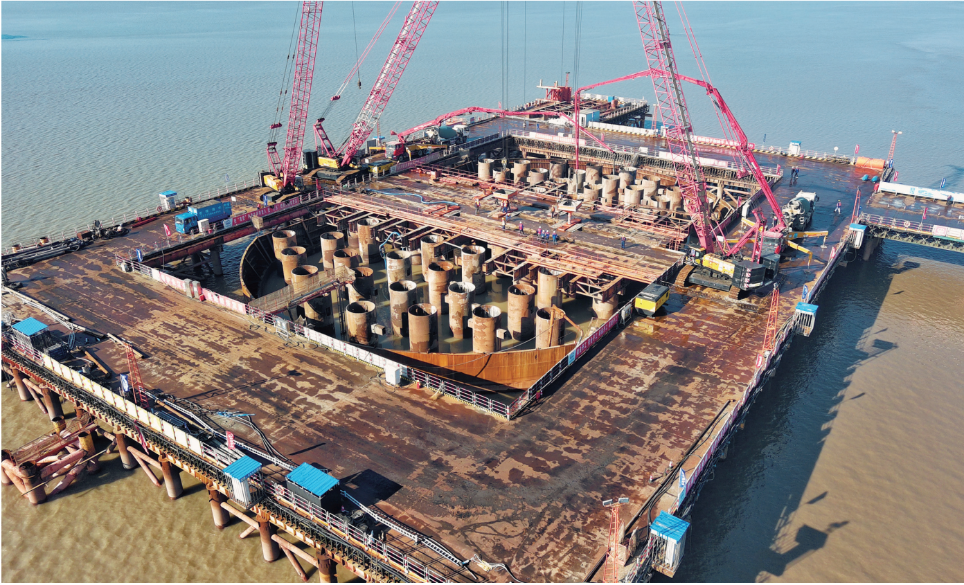
22日,在距离启东岸200米的长江入海口北支航道江面施工现场,经过近12小时的鏖战,崇启公铁长江大桥4号主墩钢围堰完成首次混凝土封底,标志着大桥即将“水落墩出”,步入主塔承台施工新阶段。
