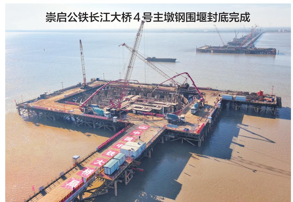
9日凌晨2时15分许，随着最后一车混凝土注入主墩围堰F2隔舱内，标志着崇启公铁长江大桥4号主墩钢围堰封底全部完成，项目建设将进入主墩施工阶段。4号主墩设计为双壁钢围堰结构，平面尺寸为72.7米×47.45米，高24.68米，面积相当于8个标准篮球场大小。
