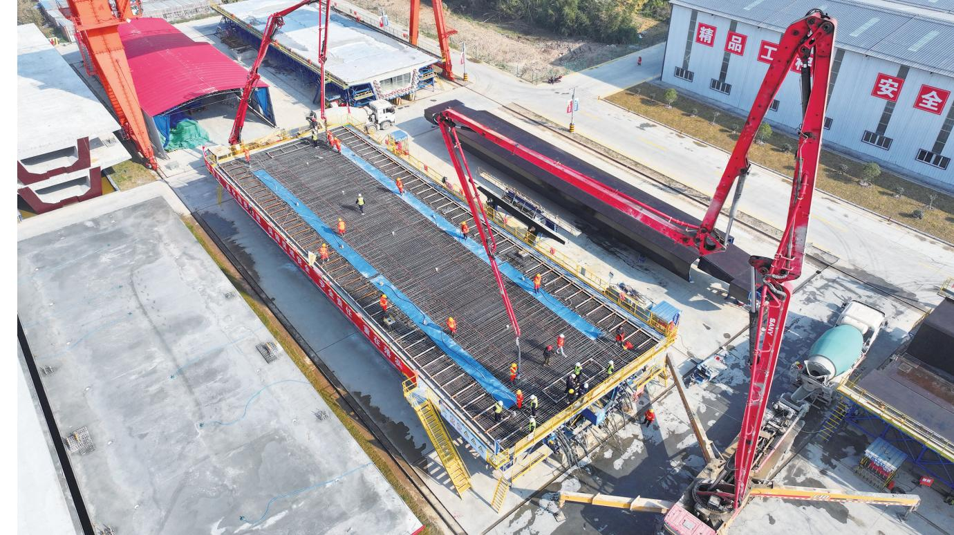
5日,工人在启东市王鲍镇境内的中铁上海工程局沪渝蓉高铁启东制梁场简支梁预制现场忙碌。据介绍,截止到7日,启东梁场完成箱梁预制65榀。沪渝蓉高铁启东制梁场主要承担沪宁段崇明站至海门北站区间共计608榀简支梁预制及架设任务,其中40米箱梁达432榀,是沪宁段唯一一家40米箱梁预制场。
