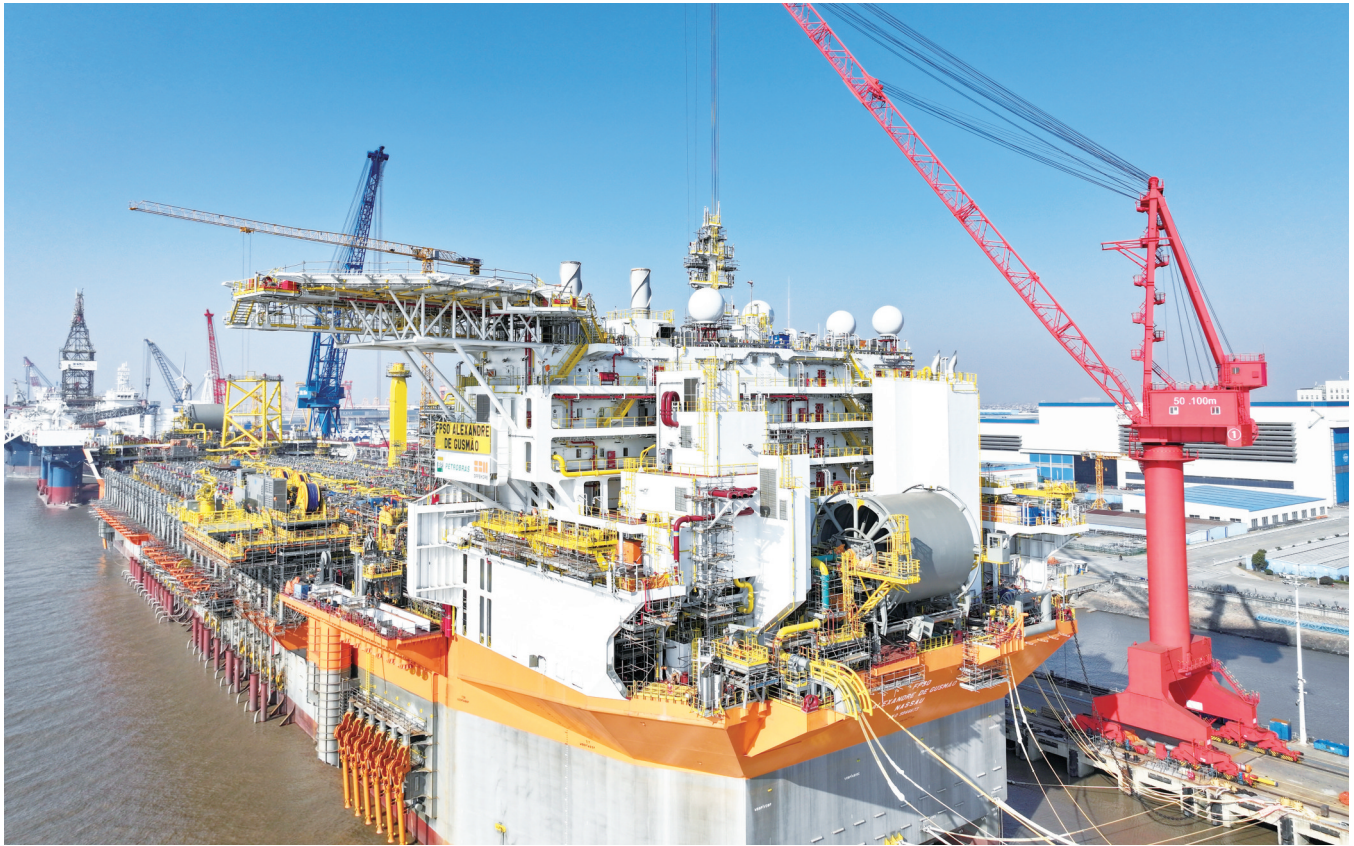
日前在启东中远海运海工码头拍摄的世界最大吨位、最大储油量新型海上浮式生产储卸油船。该船继顺利完成首批大型模块吊装后,后续11个模块安装有序推进。启东中远海运海工负责新型海上浮式生产储卸油船15个上部模块的设计、建造及项目整体总装。
