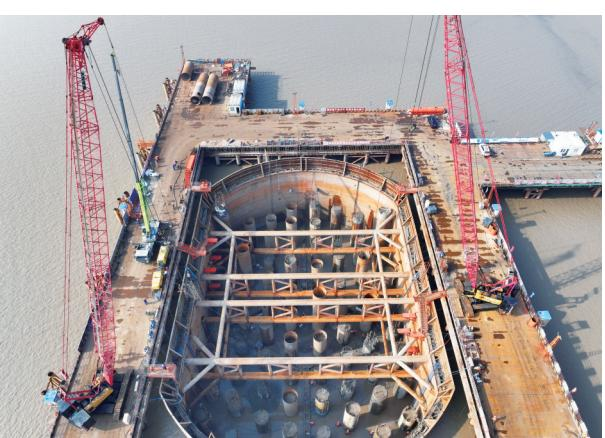
9日在启东市拍摄的由中铁大桥局施工的崇启公铁长江大桥3号、4号主塔墩大围堰施工现场。当日是三九第一天，经过一个多月的紧张施工，两个主塔墩封底排水大节全部结束，众多工人加紧进行清淤、护筒切割、桩头凿除等处理，有序推进大承台的施工作业。记者 许从军摄
